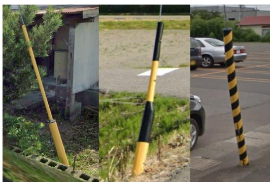
図9. 電柱の支線
