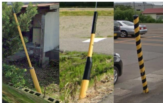
図4. 電柱の支線
